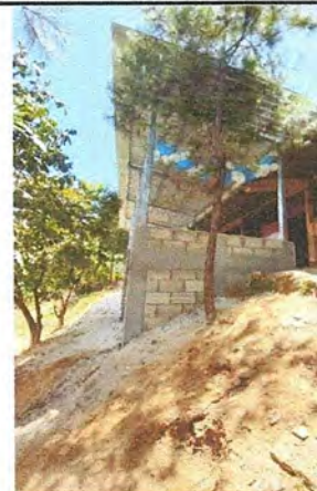
Foto 4: Area donde se realizó Mejoramiento de muro de contención, mejoramiento de muro perimetral, Mejoramiento con estructura tipo portico y lámina troquelada calibre 26 y Mejoramiento de losa de piso.
