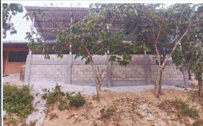
Foto 7: Area donde se realizó Mejoramiento de muro de contención, mejoramiento de muro perimetral, Mejoramiento con estructura tipo portico y lámina troquelada calibre 26 y Mejoramiento de losa de piso.
