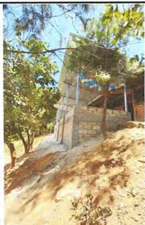
Foto 3: Area donde se realizó Mejoramiento de muro de contención, mejoramiento de muro perimetral, Mejoramiento con estructura tipo portico y lámina troquelada calibre 26 y Mejoramiento de losa de piso.
